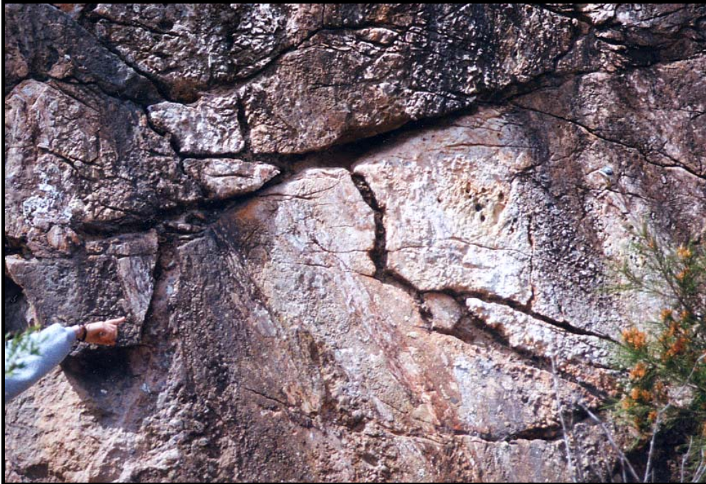
Figura 11: Superfície d'una diàclasi on s'observen fissures engrandides i obertes per dissolució de la roca calcària.
