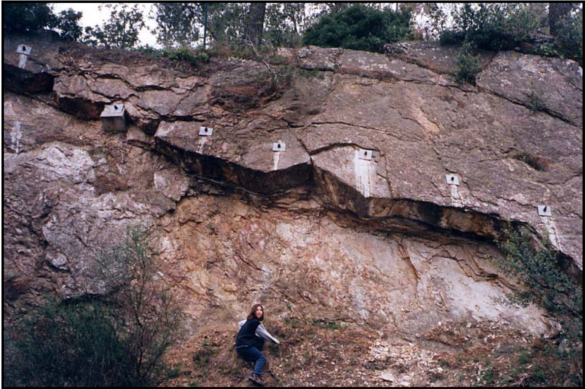
Figura 7: Ancoratge d'una capa que estava esllavissant cap a la carretera Gavà-Begues.
